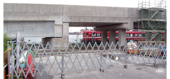
高架事業が進む三河知立一三河八橋間
